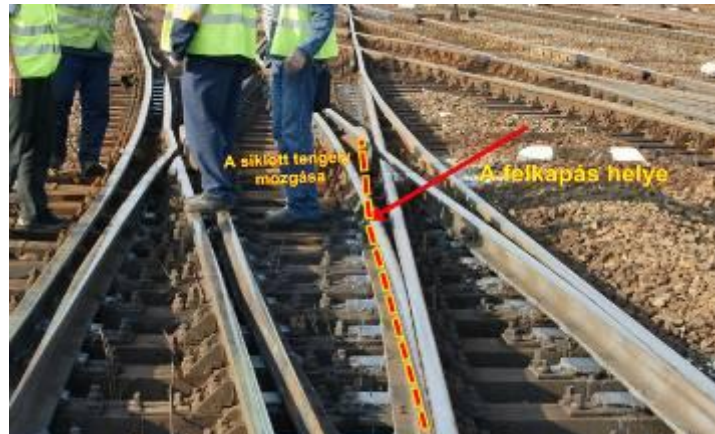
14. ábra: A siklott kocsi haladási iránya a kitérőben
