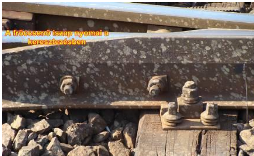
13. ábra: Lokális pályahiba a II. sz. keresztezésben
