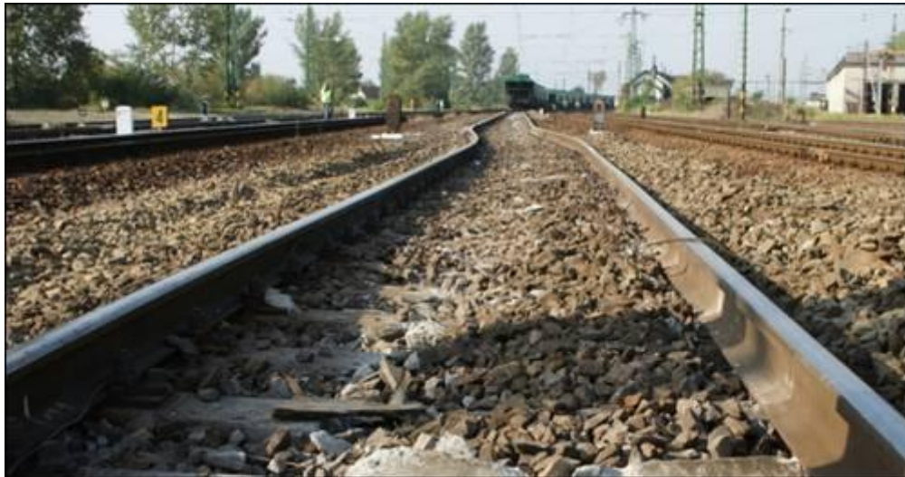
5. ábra: A megrongálódott pálya az eset helyszínén
