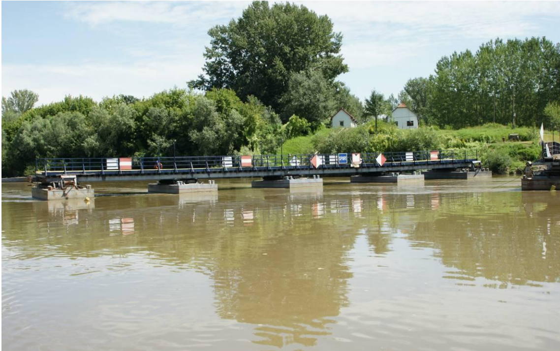
3. sz. ábra: A pontonhíd középső része, amely a híd nyitott állásában a jobb partban van kikötve
