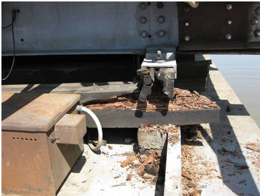
7. sz. ábra: A pontonhíd összetört máglyafái
