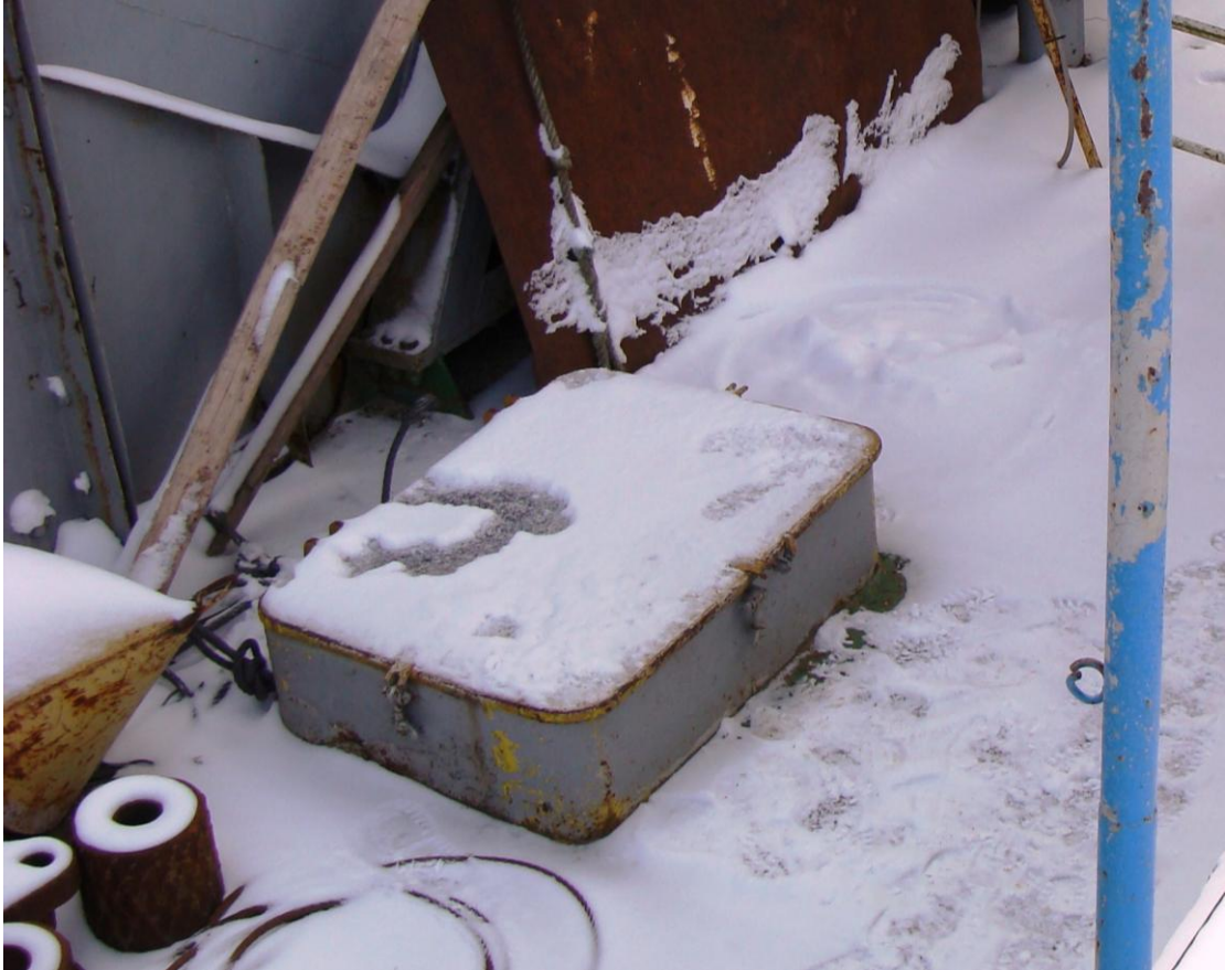
5. sz. ábra: A búvónyílás fedél
