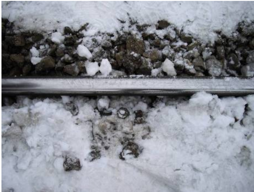
7. ábra: gyalulási, marási nyom
