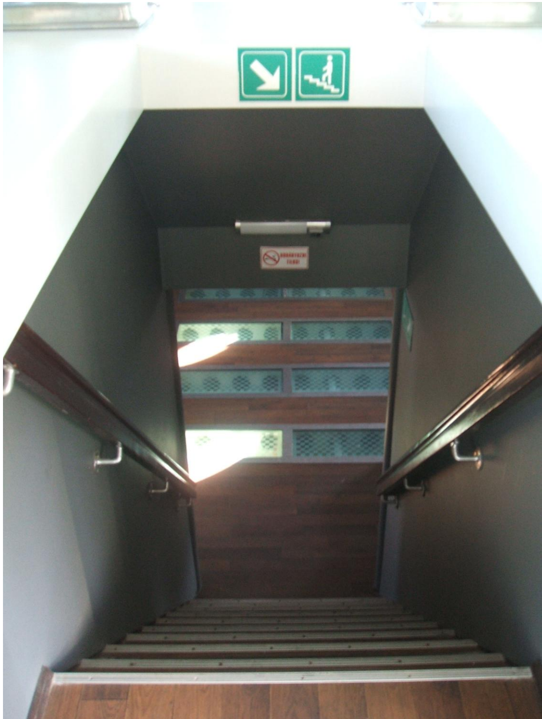
1. sz. ábra: A lépcsőlejáró, erős korláttal, a lépcsőfokokon csúszásgátló betéttel, jól látható jelzésekkel
