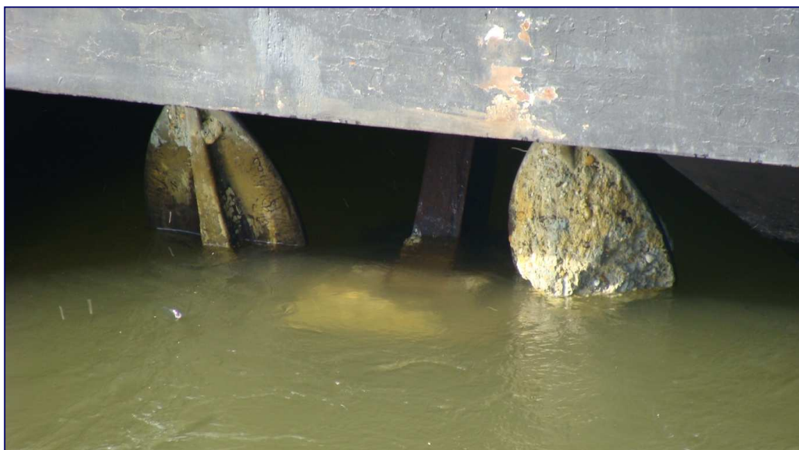
2. ábra: A horgonykapákon látszik a kavicsos márgás üledék.
