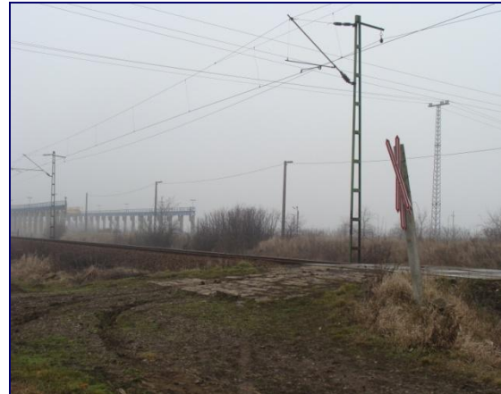
10. ábra Az útátjáró a gépkocsi haladási iránya felől (2009. III. 4.)
