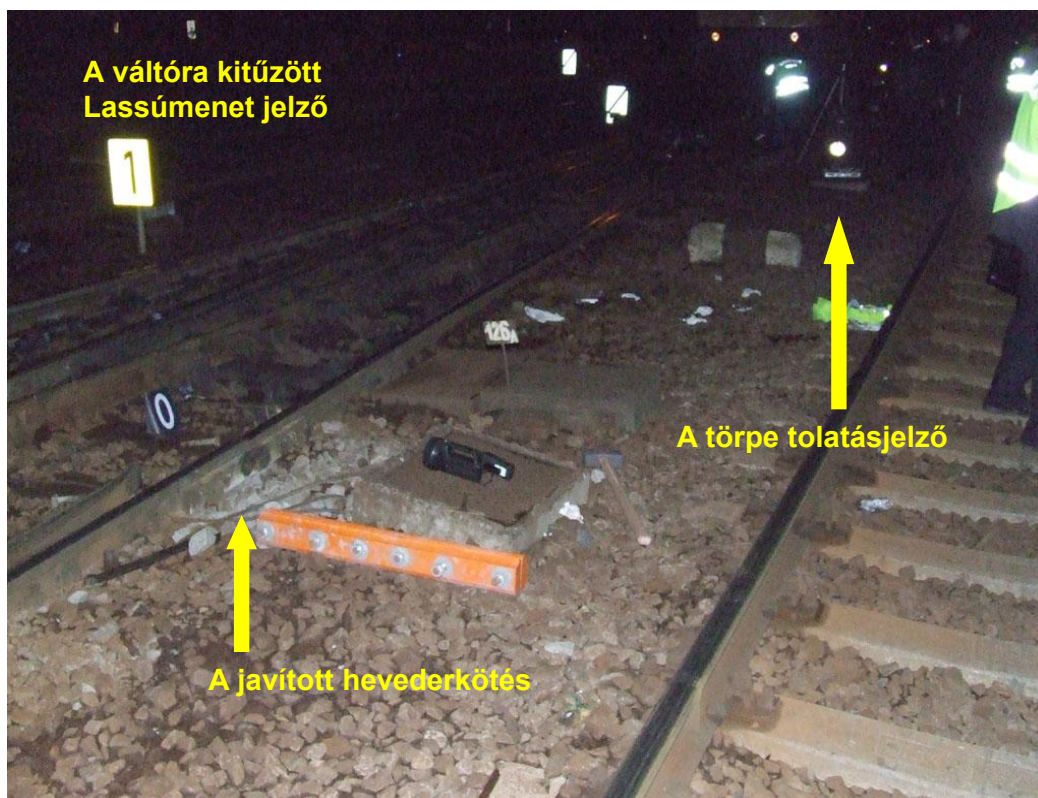
10. ábra: a munkavégzés helye és a törpe tolatásjelző
