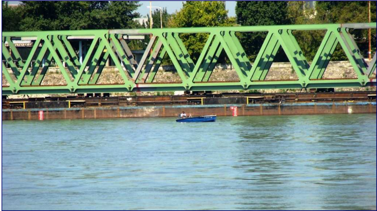
5. sz. ábra: A beépítendő hídelem
