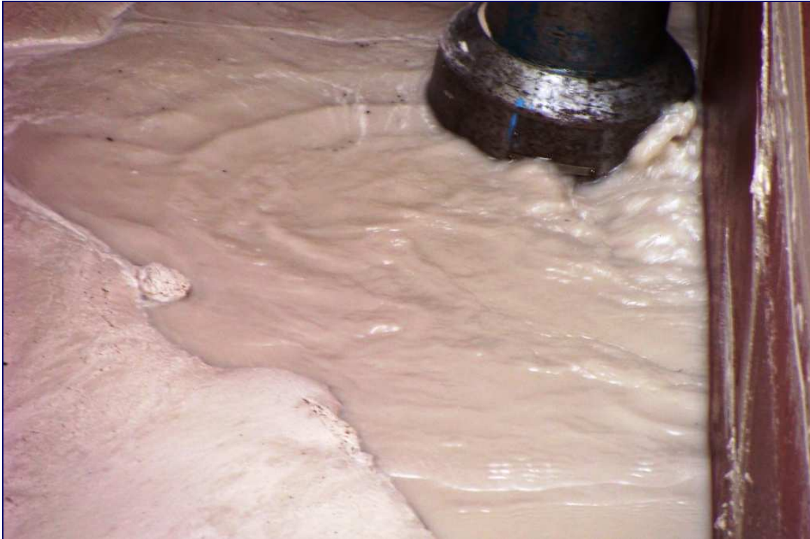
6. sz. ábra: A Wiking ms. I. sz. raktár szivattyúzása. A raktárban az áru elázott.
