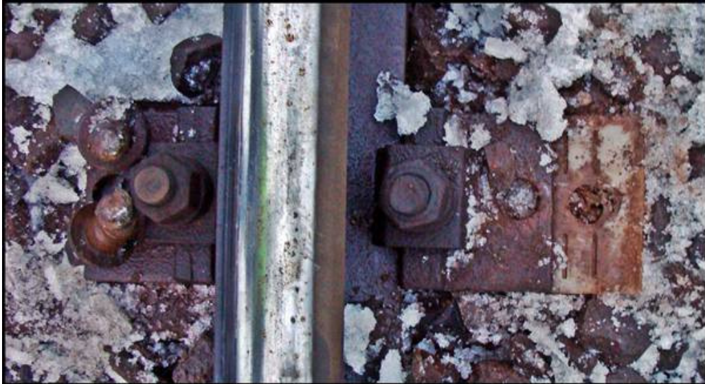
12. ábra: A sérült leerősítések egyike az eset helyszínén
