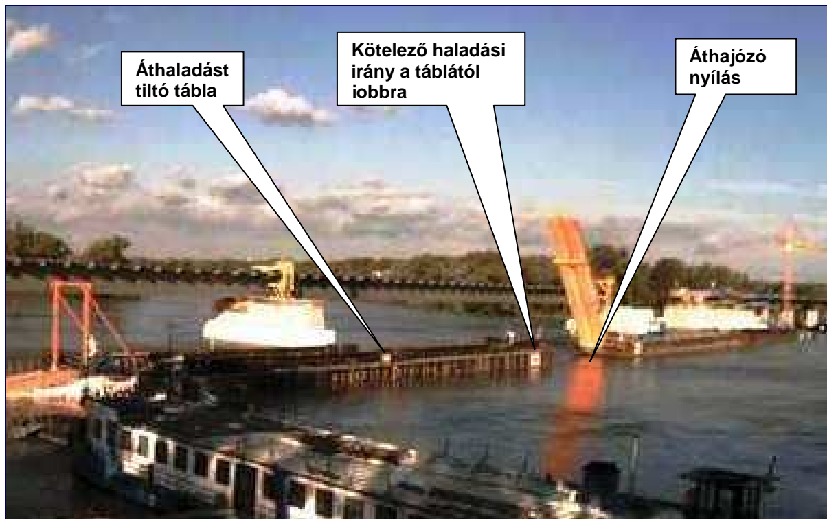
5. sz. ábra: A pontonhíd, háttérben az épülő hídpillérek
