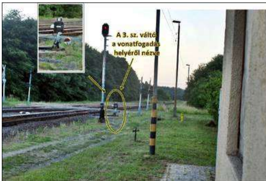
13. ábra: A 3. sz. váltó megfigyelhetősége a váltókezelő vonatfogadásra kijelölt helyéről
