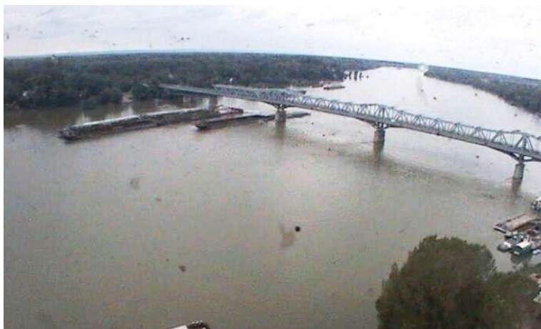
2. sz. kép: a tolatmányról leszakadt két bárka a hídníllásban (forrás: ADUVIZIG)
