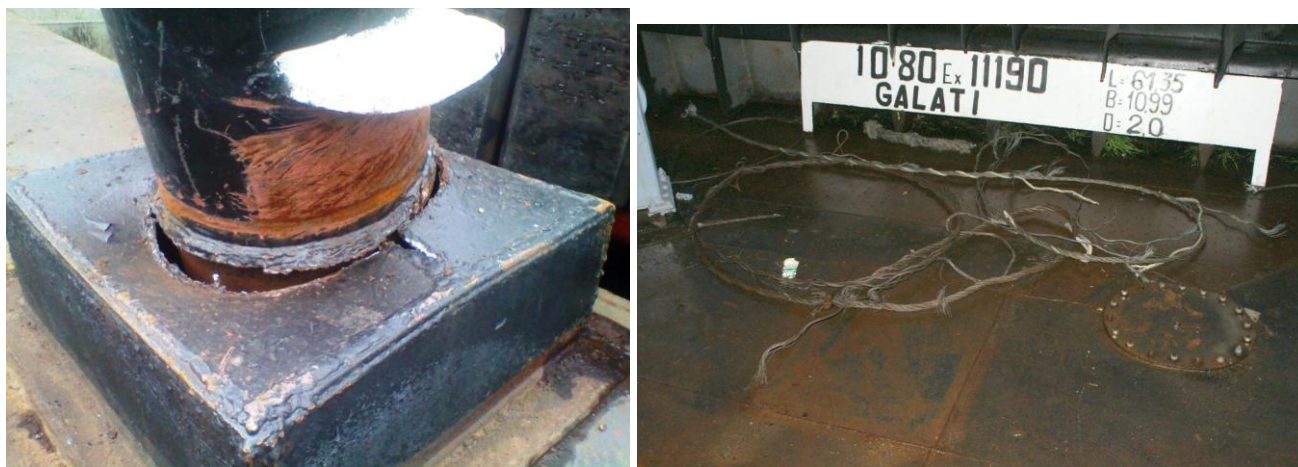
6-7. sz. kép: A kismértékű sérülés a bárka kikötő bakján és a szakadt kötelek
