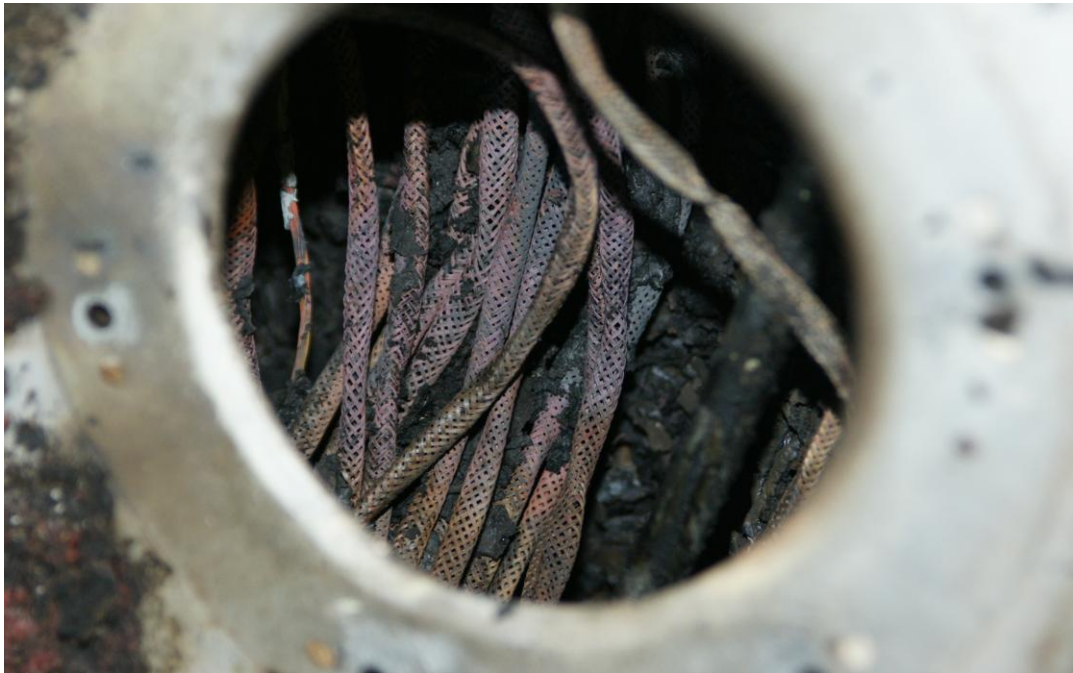
2. ábra Megégett vezetékek és koaxiális kábelek
