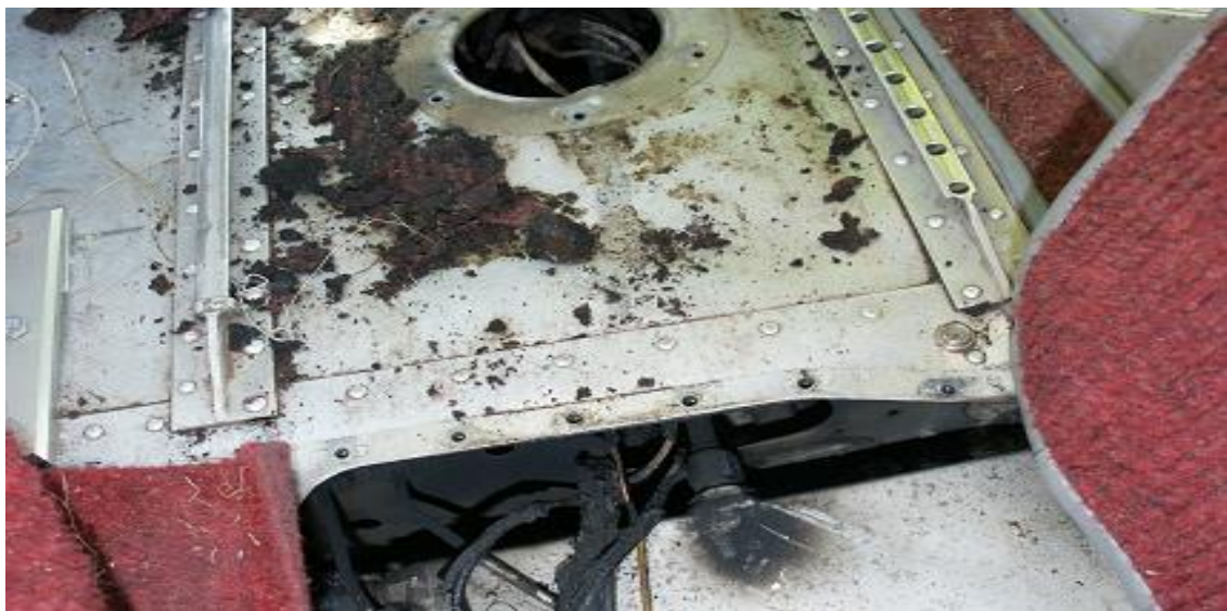
1. ábra Égésnyomok a padlólemez szerelőnyílásának környékén.
