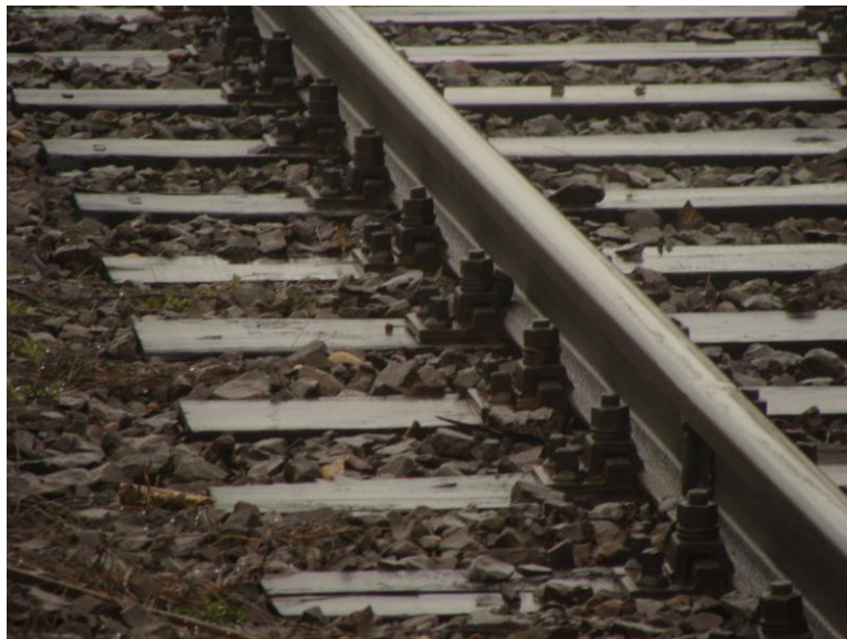
4. ábra kifelé dőlő kapcsolószerkezetek (külső sínszálon)
