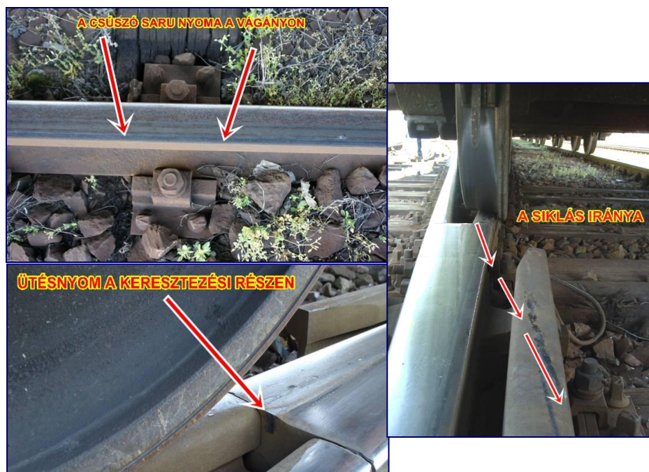
9. ábra: Siklási nyomok a vágányon és a kitérőben
