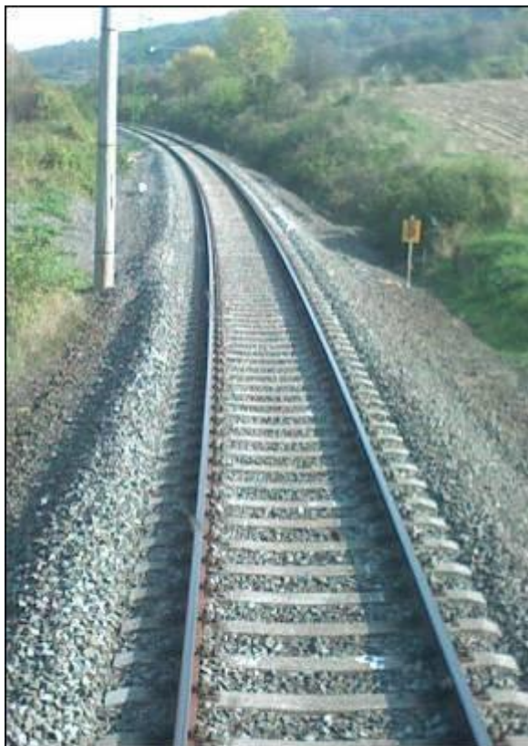
13. ábra. Kitűzött lassúmenet a helyreállítás után
