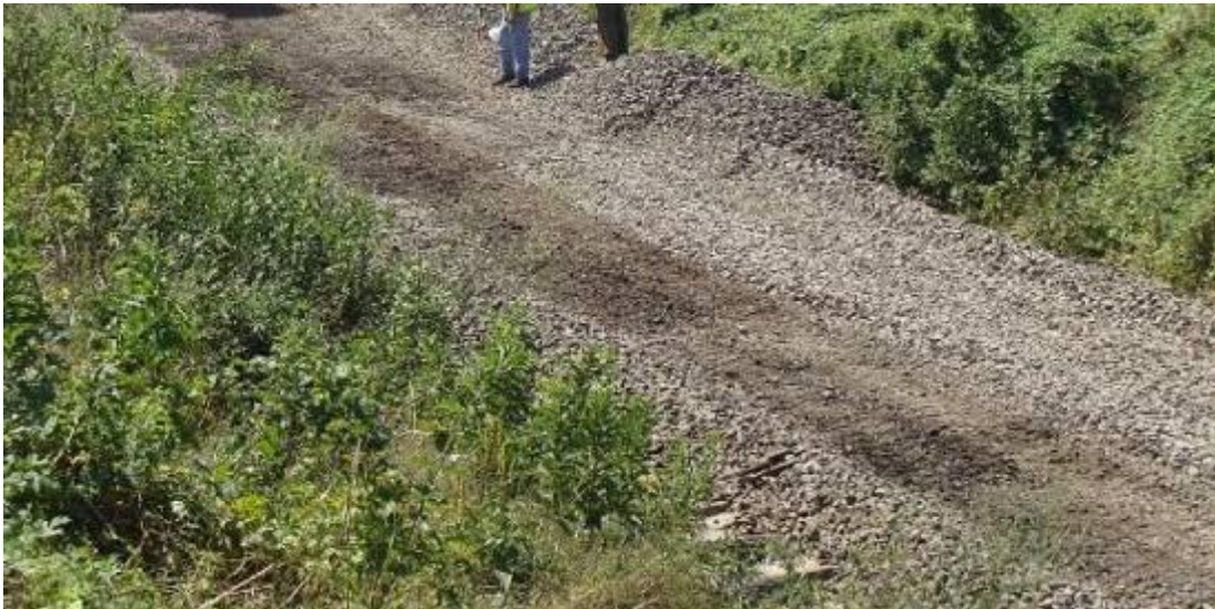
10. ábra: Átázott alépítmény a helyreállításakor (2008. augusztus 04.)
