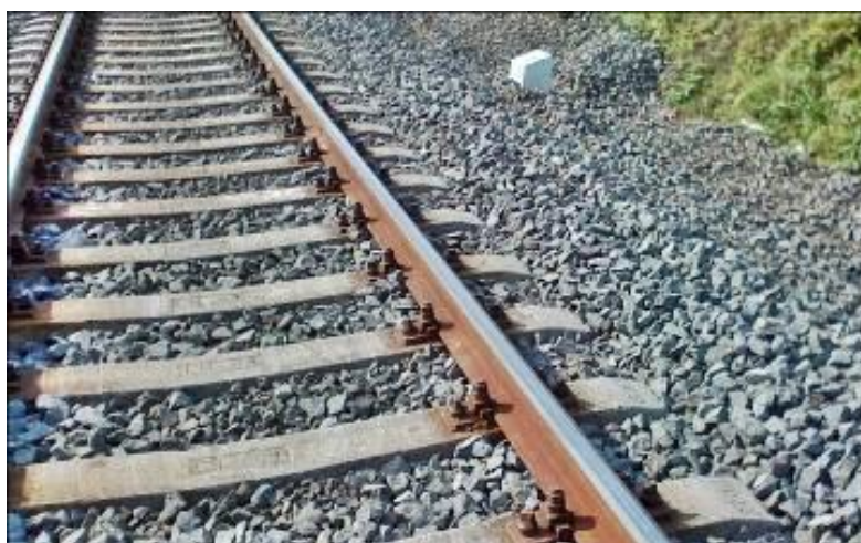
14. ábra: A vízelvezetési problémákat nem oldották meg
