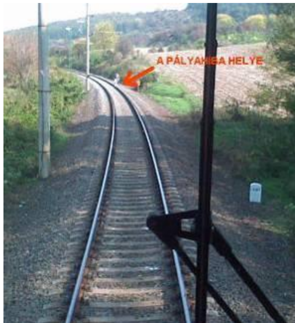
10. ábra: A pályahiba észlelhetősége a mozdonyról (A fénykép a helyreállítás után tartott műszaki szemlén készült)
