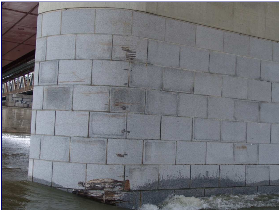
Súrolási nyomok a Lágymányosi híd pillérén
